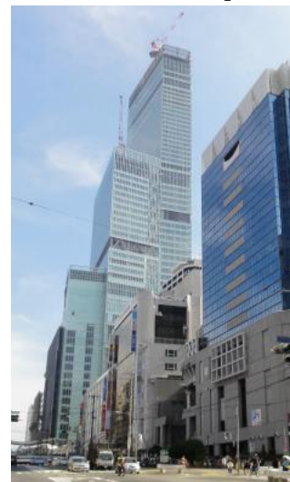
写真 3-2 建設中の 「あべのハルカス」
